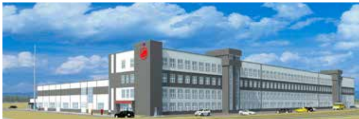
Новый корпус НПП Буревестник, ОАО
